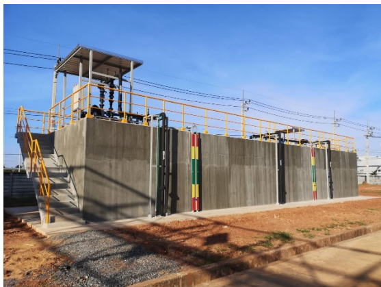
รูปที่ 2-6 บ่อ Emergency Pond ขนาด 180 ลบ.ม. และบ่อ blow down ขนาด 100 ลบ.ม.
