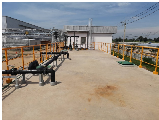
รูปที่ 2-6 บ่อ Emergency Pond ขนาด 180 ลบ.ม. และบ่อ blow down ขนาด 100 ลบ.ม.
