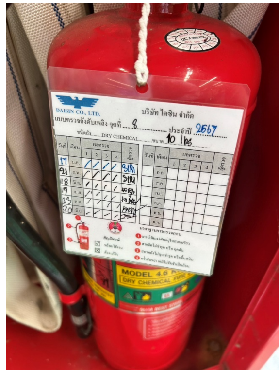
รูปที่ 2-53 การตรวจสอบอุปกรณ์ป้องกันอัคคีภัย
